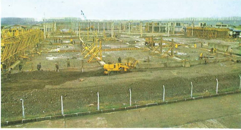
Tevsi Projemiz İle İlgili İnşaat Faaliyetimizden Bir Görünüm
