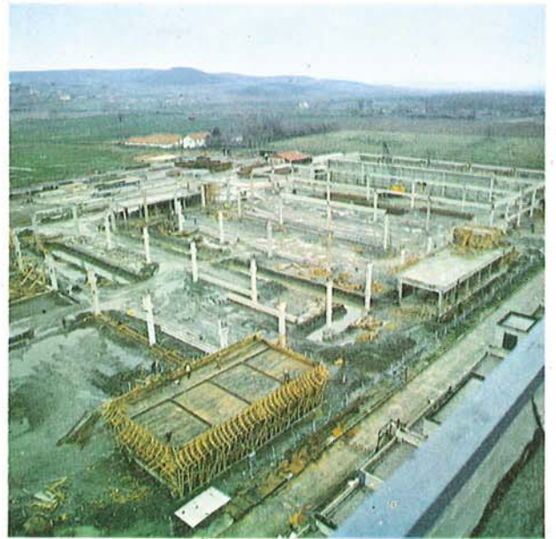
Tevsi İnşaatımızdan Diğer Bir Görünüş
